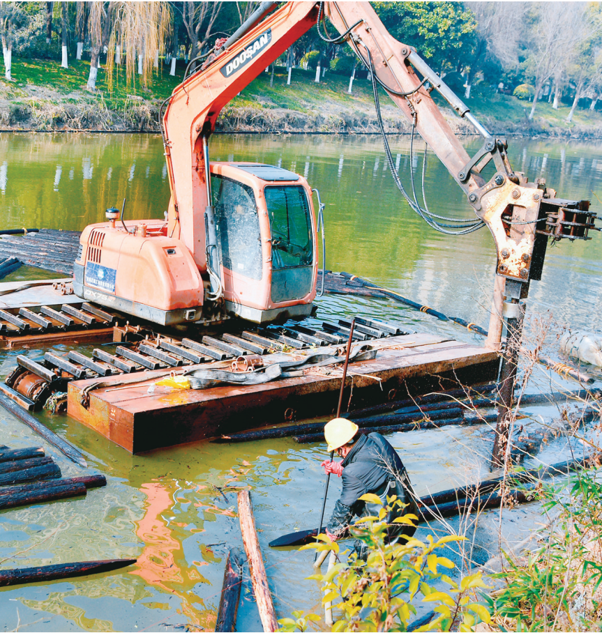
13日，施工人员在如皋龙游河（惠政东路至福寿东路段）进行木桩护坡施工。如皋针对部分河道水土流失严重情况，进行生态修复和岸坡治理，营造“河畅、水清、岸绿、景美、宜居”的生态环境。
