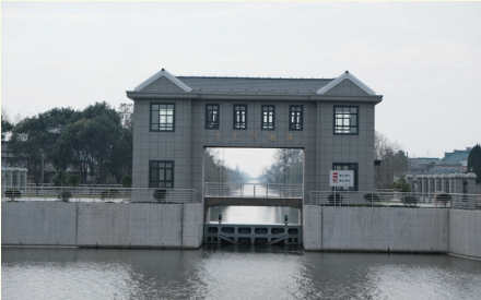
新建成的海安立公河地涵,是一座上层为单孔闸门、下层为双孔箱涵的“水上立交”,为海安栟北片构建高低分开、引排有序的自然活水格局提供了有力支撑
