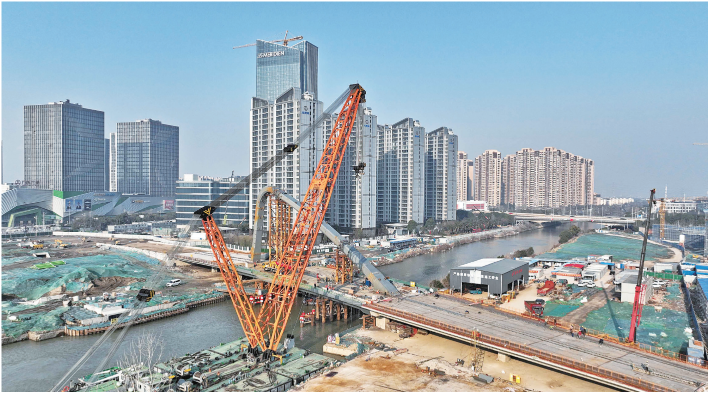
28日,位于崇川区五龙汇片区的永昌路大桥跨径76米的下承式系杆拱桥桥台合龙。永昌路大桥横跨通扬运河,将永昌路与百园路贯通,全长约600米,规划双向4车道。
