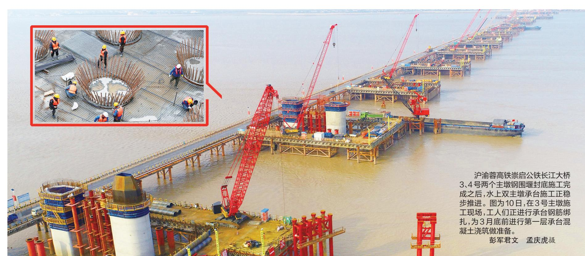
沪渝蓉高铁崇启公铁长江大桥3、4号两个主墩钢围堰封底施工完成之后,水上双主墩承台施工正稳步推进。图为10日在3号主墩施工现场,工人们正进行承台钢筋绑扎,为3月底前进行第一层承台混凝土浇筑做准备。
