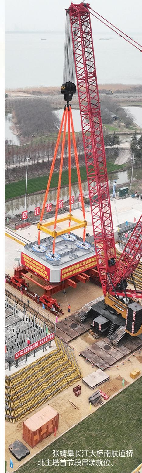
张靖皋长江大桥南航道桥北主塔首节段吊装就位。
