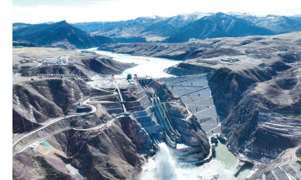
4月1日,玛尔挡水电站首台5号机组正式并网发电。该水电站位于青海省海南藏族自治州同德县与果洛州玛沁县交界处的黄河干流上,项目所在地平均海拔3300米,总装机容量232万千瓦,是黄河流域在建海拔最高、装机最大的水电工程。新华社照片
