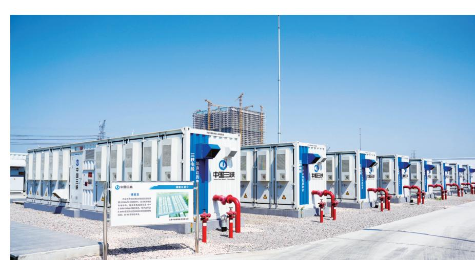
电化学储能站,它区别于常规用户侧储能,是独立型的储能电站,在电网中的作用相当于一个巨型共享“充电宝”,能够
