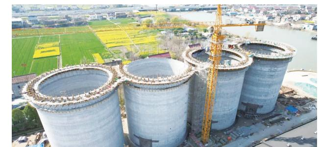
本报讯 (记者 王颖)近日，记者从南通粮食集团获悉，储备粮公司4座浅圆仓滑模施工顺利完工，标志着储备粮公司浅圆仓项目主体结构完成重要施工节点，为整个工程竣工打下坚实基础。
