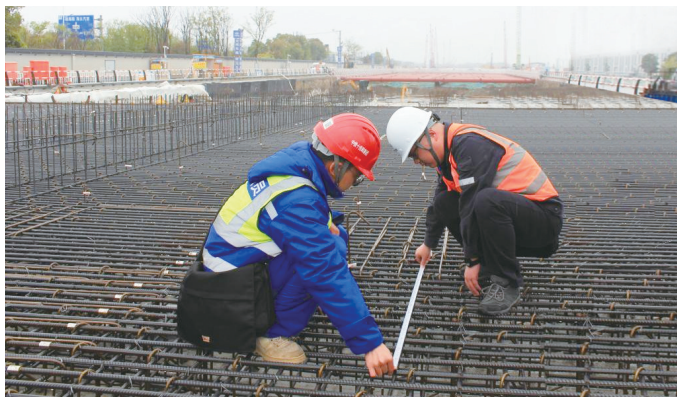
8日，海太长江隧道(公路部分)工程项目HT-A1标北接线(南通段)迎来重要节点——项目敞开段400米(第四十二流段)首块底板浇筑完成。图为施工人员正在现场验收钢筋和模板。 彭军君文 戈德旺摄
