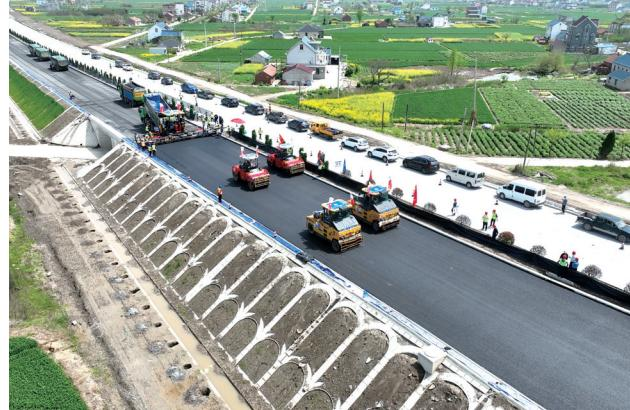
本报讯（通讯员曹建明 记者徐书影）15日下午，洋通高速二期工程施工现场一片繁忙景象，在1台大宽度摊铺机、4台胶轮压路机、3台双钢轮压路机的同时作业下，沥青下面层试验段摊铺顺利完成，标志着洋通项目“刷新”进度，正式进入沥青路面施工阶段。
