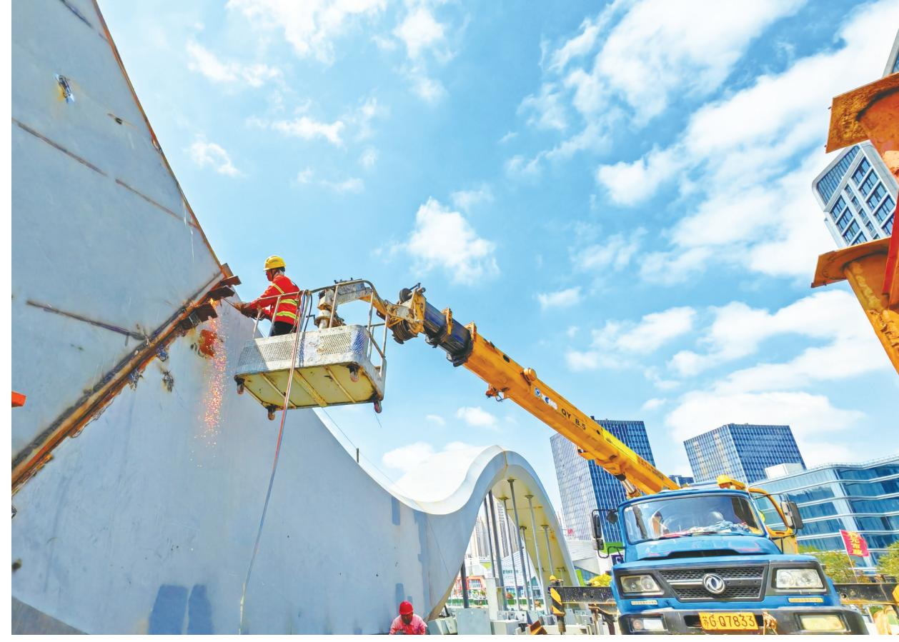
昨天，施工人员正在五龙江片区的永昌路大桥桥面施工。永昌路大桥横跨通扬运河，全长约600米，规划双向4车道，目前进入桥面美化阶段。大桥在设计上与邻近的城闸大桥保持协调一致，主拱造型与乐器竖琴相仿，拱为琴头，拉索为琴弦，立面搭配五道波浪元素，奠定五水的蓬勃基调。
