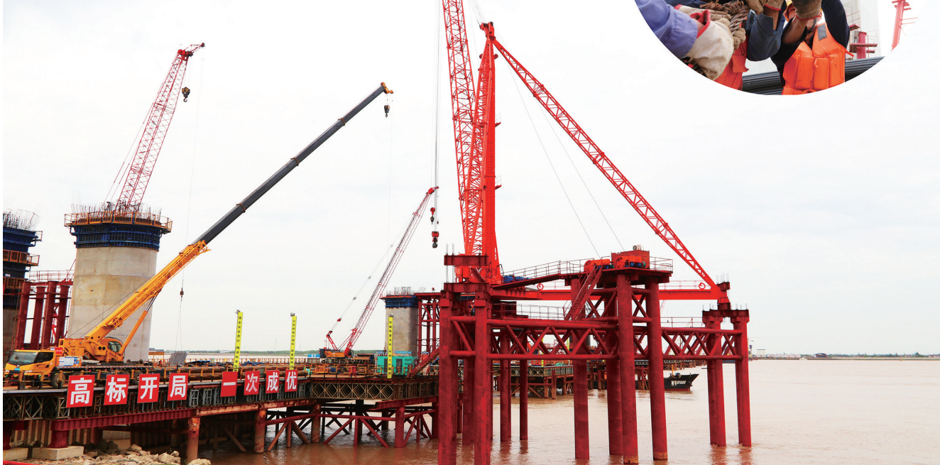
25日，中铁大桥局承建的崇启公铁长江大桥水上120吨桅杆式起重机和120吨龙门式起重机均试吊成功，标志着两台起重机能够胜任即将进行的非通航孔桥3.8万吨钢梁顶架梁任务。 彭君君文 孟庆虎 吴吉摄
