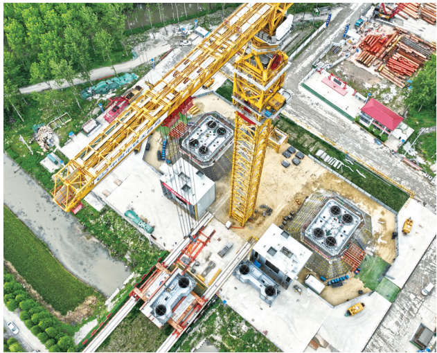
昨日，张靖皋长江大桥南航道桥北主塔区域开启主塔钢节段吊装作业新节点。截至下午5时许，1.5万吨米塔式起重 机(详见A2版)已完成两节400余吨的钢节段吊装作业。据了解，此次主塔钢节段吊装作业共有8节钢节段，预计11日完成。 记者 丁彬彬摄
