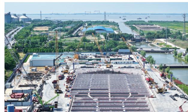
24 日拍摄的由中铁十四局承建的海太长江隧道 HT-A1 标工程施工现场。据介绍，该标项目部正在进行结构混凝土施工，土方基本结束，42 块底板混凝土预计 6 月初全部结束，盾构机正在加紧制造。
