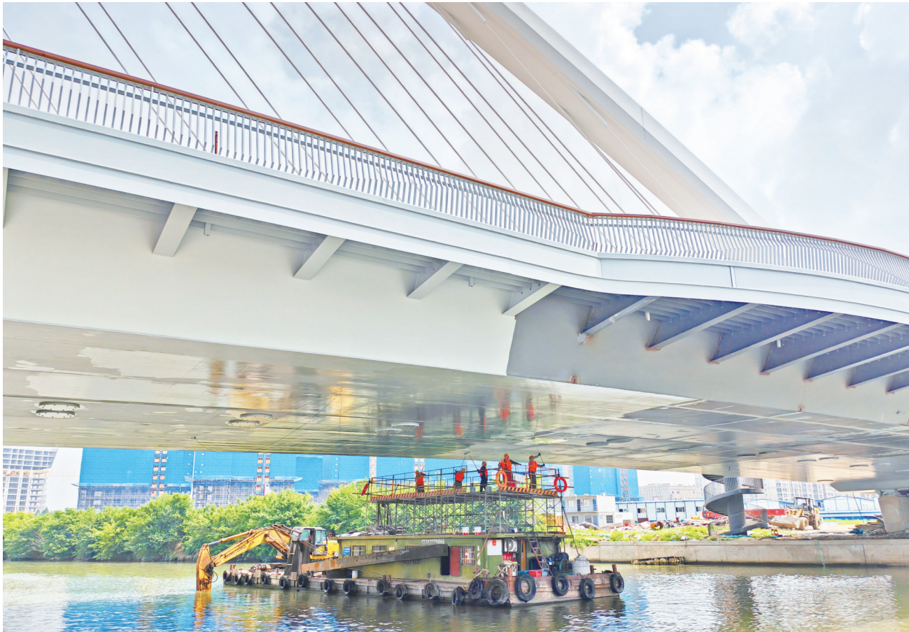
昨日，施工人员正在崇川区五龙汇片区的永昌路大桥建设工地给桥底立面涂刷油漆、周边配套路面铺设沥青，力争本月底按时竣工。
