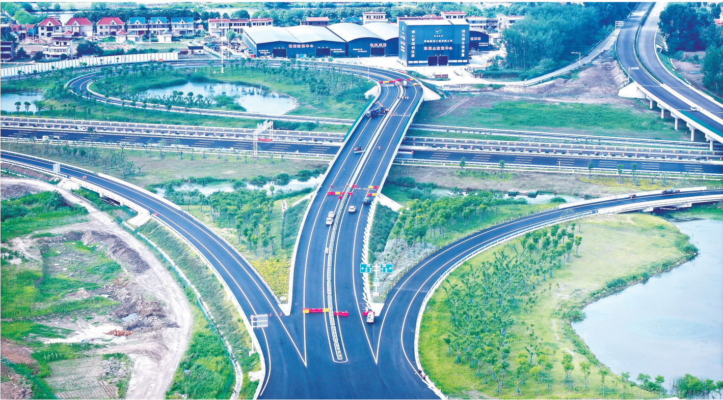
20日在如皋九华拍摄的G40沪陕高速公路平潮至广陵段扩建工程九华互通新貌。九华互通采用双喇叭形方案原位改建,互通立交共包括7个匝道桥,下部结构均为盖梁、柱式墩、肋板式桥、钻孔灌注桩,上部结构为装配式预应力砼箱梁、预应力空心板梁。记者 许丛军摄
