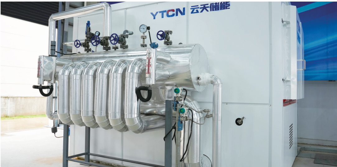
运行中的200千瓦固体电蓄热供热机组。
