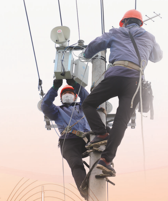
电力工人正在高空作业，维护通信线路
