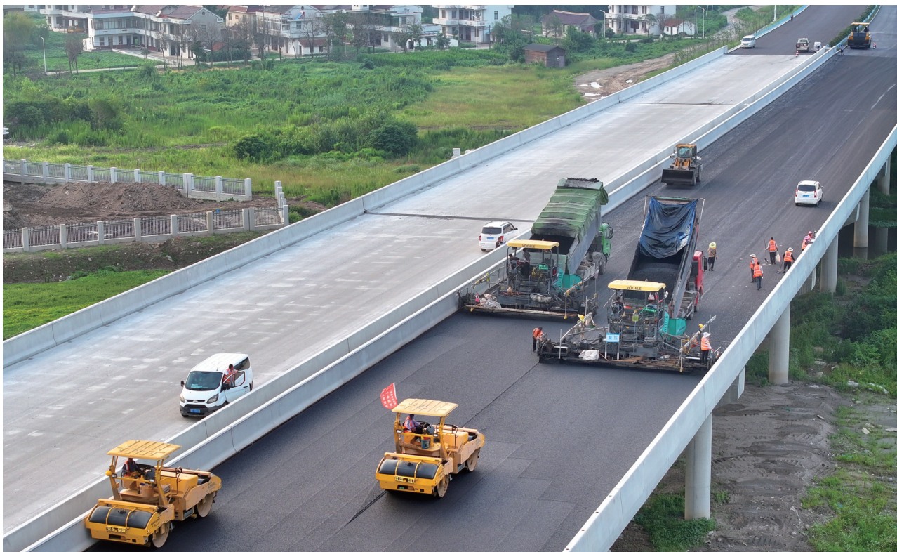
19日在通州区拍摄的南通绕城高速公路海门至通州段沥青摊铺现场。南通绕城高速是江苏省首条引入社会资本投资的高速公路,项目全长约65.4公里,按双向六车道高速公路标准建设,目前各项工程正按序时进度稳步推进。 记者 许丛军摄
