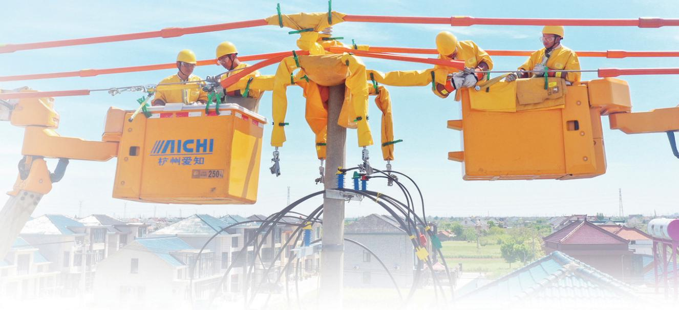
全力守护电力“生命线”，除了加强地面巡检，如东县供电公司也在空中排查方面也丝毫不敢松懈。上午9时许，烈日当空。在丰利镇10千伏丰北线102号杆处，带电作业人员穿着厚厚的绝缘服，站在10多米高的作业车斗上，进行带电作业。
