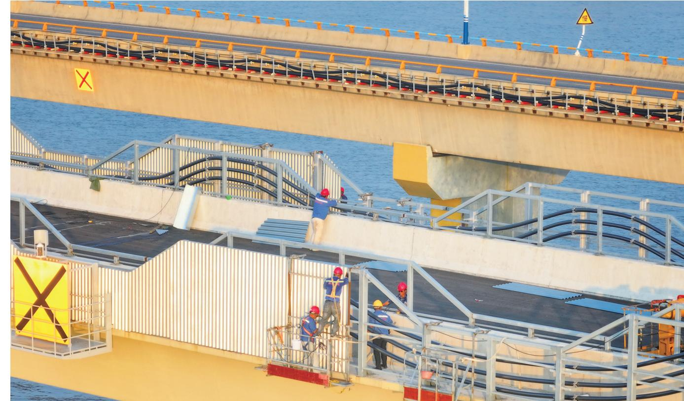
昨天日出时分拍摄的江苏省综合交通运输体系重点项目——洋口港黄海大桥二桥。施工人员正在安装护栏,为近期通车做准备。黄海大桥二桥是洋口港的重大基础设施配套工程,桥梁总长约10公里,行车道净宽9米,建成后与大桥合并使用,组成双向四车道的一级公路,将极大缓解黄海大桥的承载压力,有效满足港区吞吐量快速增长的需要。
