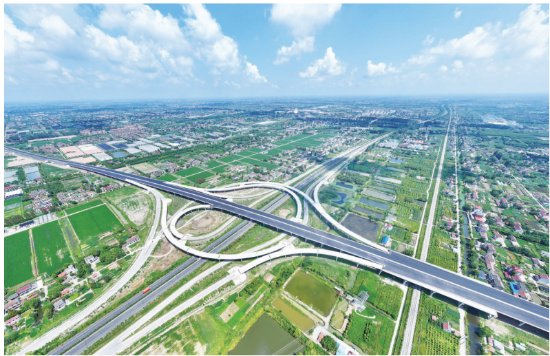
28日拍摄的南通绕城高速海门东枢纽新貌。据交通运输局提供的信息，目前绕城高速全线主线沥青下面层已基本完成，中面层完成近70%，上面层完成23%，匝道沥青摊铺同步进行中，房建工程均已进入室内装修、场地施工阶段，机电、交安等附属工程也在有序推进。 记者 许丛军摄
