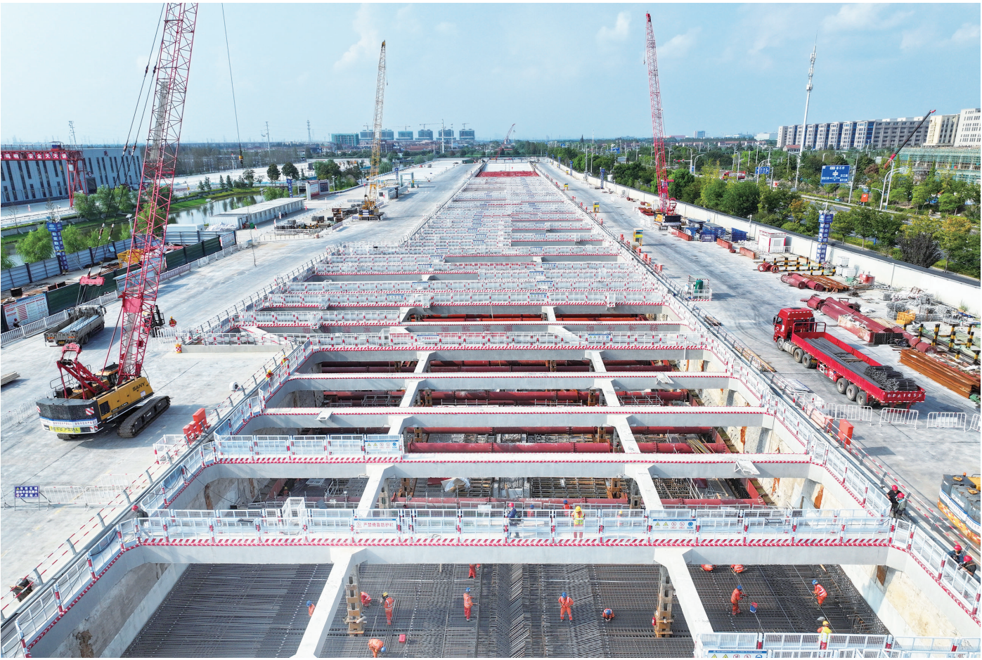
昨天拍摄的海太长江隧道HT-A1标工程施工现场。据省交建局提供的信息,目前,海太长江隧道江北段明挖隧道围护结构已全部完成,正在开展主体结构施工;江南段明挖隧道正在开展围护结构施工,盾构段管片厂已建设完成并正式生产。
