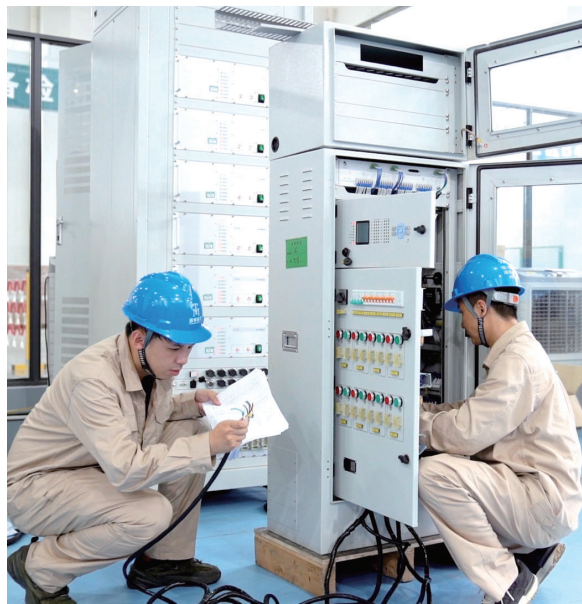
供电公司员工正在调试配电设备检测平台。 袁东方泉摄
