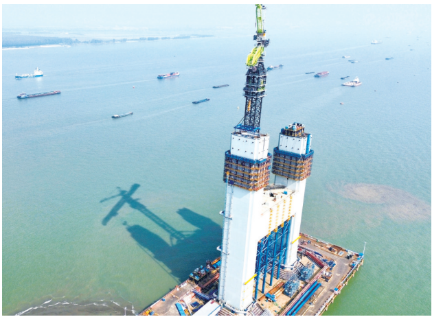
11日,在张靖皋长江大桥南主塔的水中施工现场,经中交二航局数十名施工人员齐心协力,重达460余吨的上游第11节段钢箱完成精准拼装,至此,主塔高度突破百米大关,达到110米,相当于40层住宅楼的高度。大桥南航道桥主塔预计明年年底封顶,高度达350米,建成后将成为世界最高悬索桥索塔。 记者 彭军君文 通讯员 张正培摄
