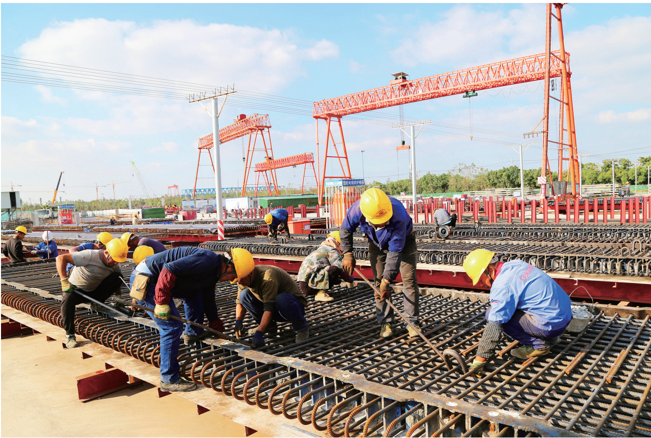
崇启公铁长江大桥公路 预制桥面板施工启动
