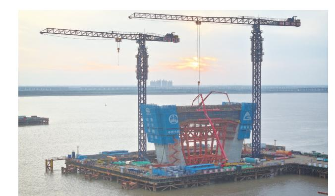
昨日18时18分，启东长江入海口北支航道江面施工现场，经过近25个小时连续浇筑，由中铁大桥局承建的崇启公铁长江大桥4号主塔下横梁及其塔柱连接段首层浇筑完成，标志着大桥迈入新的施工阶段。主塔下横梁相当于大桥的“肩膀”，是未来桥面的重要支撑结构。彭军君文 许从军摄
