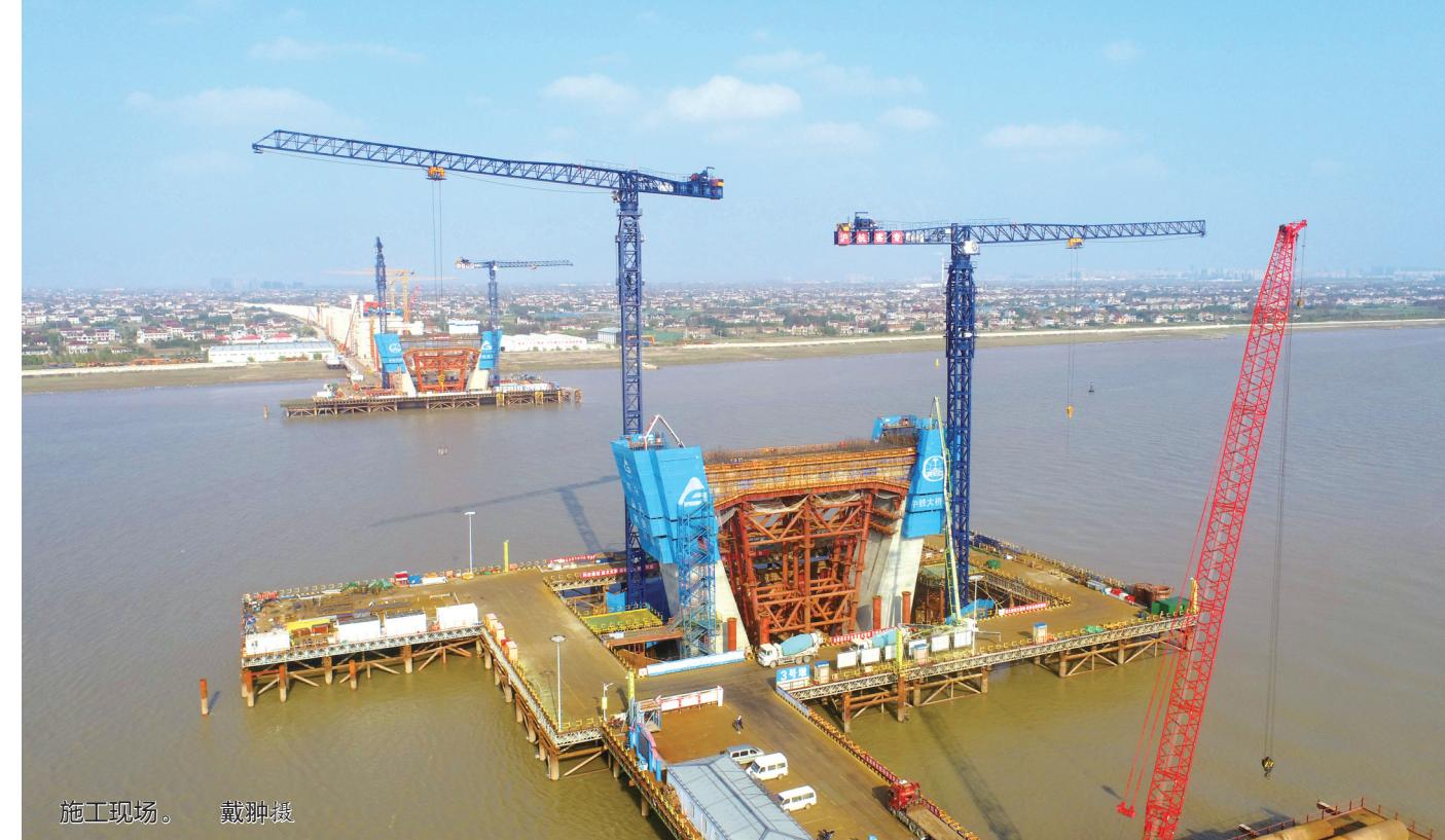
崇启大桥3号主塔墩下横梁首层浇筑完成
