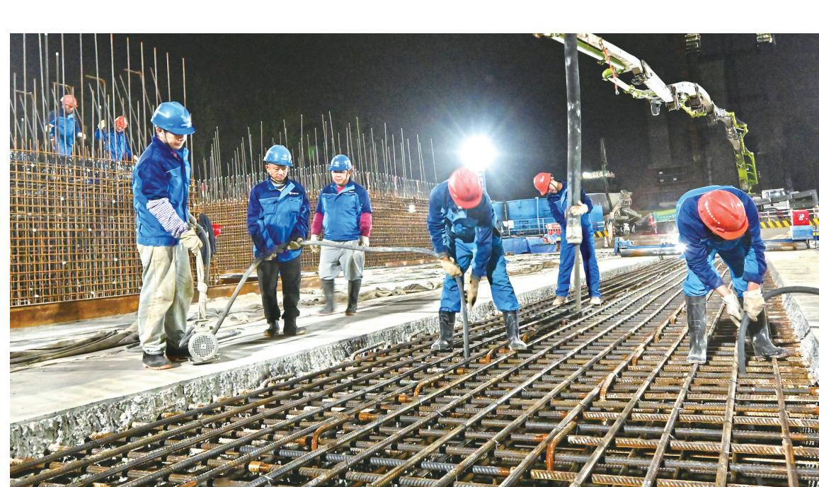
昨天凌晨，张靖皋长江大桥建设迎来新节点。随着500余立方米混凝土浇筑完成，张靖皋长江大桥首个锚碇基础成功浇筑，为后续施工奠定良好基础，项目建设开始从“地下”转为“地上”。
