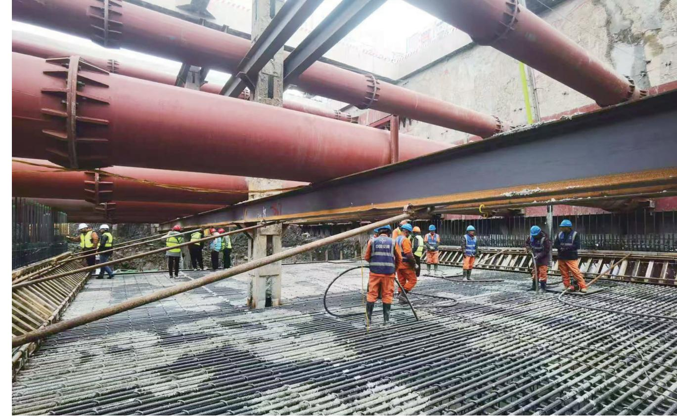
本报讯（记者彭军君 通讯员李颜东 戈德旺）22日，在经过10余个小时的紧张施工后，海太长江隧道江南段的首块底板完成浇筑，为后续主体结构施工筑牢基础。
