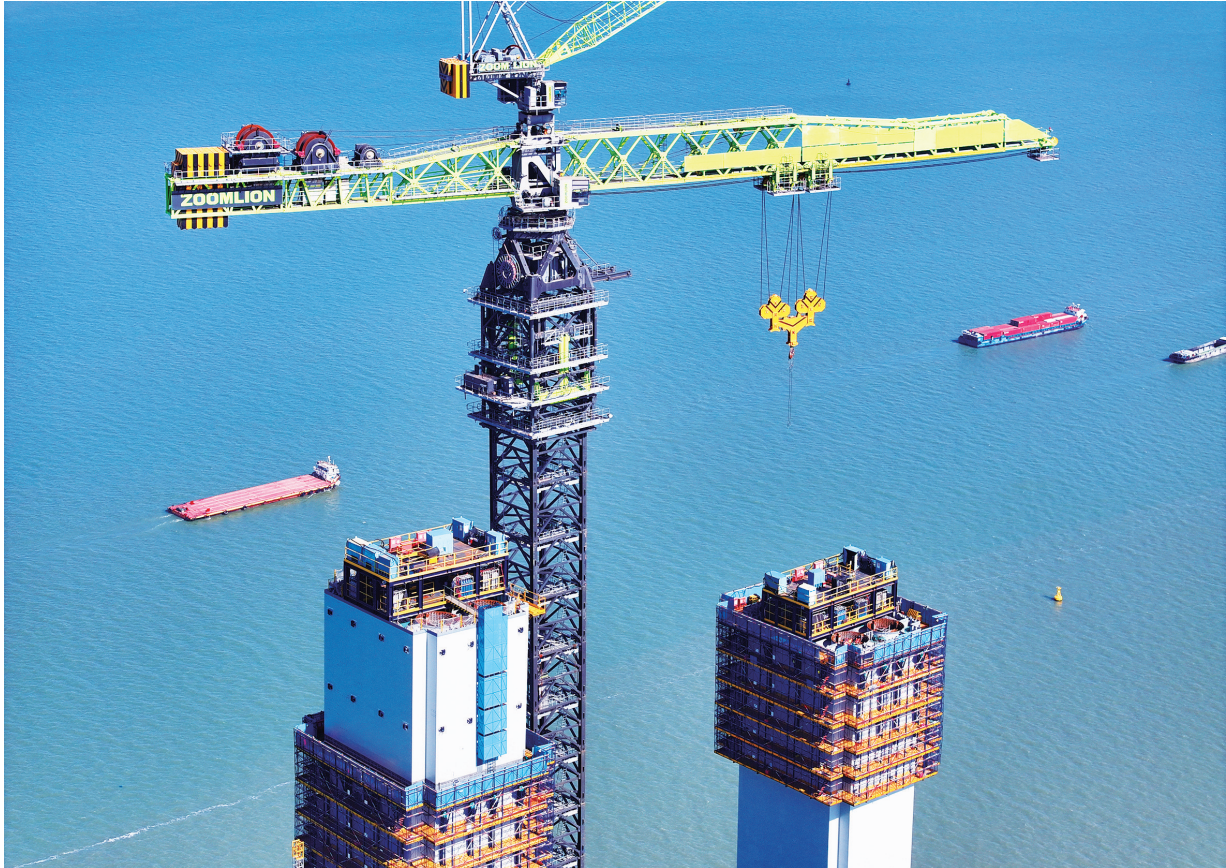
8日拍摄的由中交二航局施工的世界最大跨度桥梁张靖皋长江大桥南航道桥南主塔施工现场。节后各工点陆续开始施工,处处一片繁忙景象。目前中交二航局张靖皋长江大桥南航道桥南主塔正在进行第18个节段施工,目前主塔高度已接近200米。据介绍,南主塔是大桥唯一一座江中主塔,塔高设计为350米,是世界第一悬索桥高塔。 记者 许丛军摄
