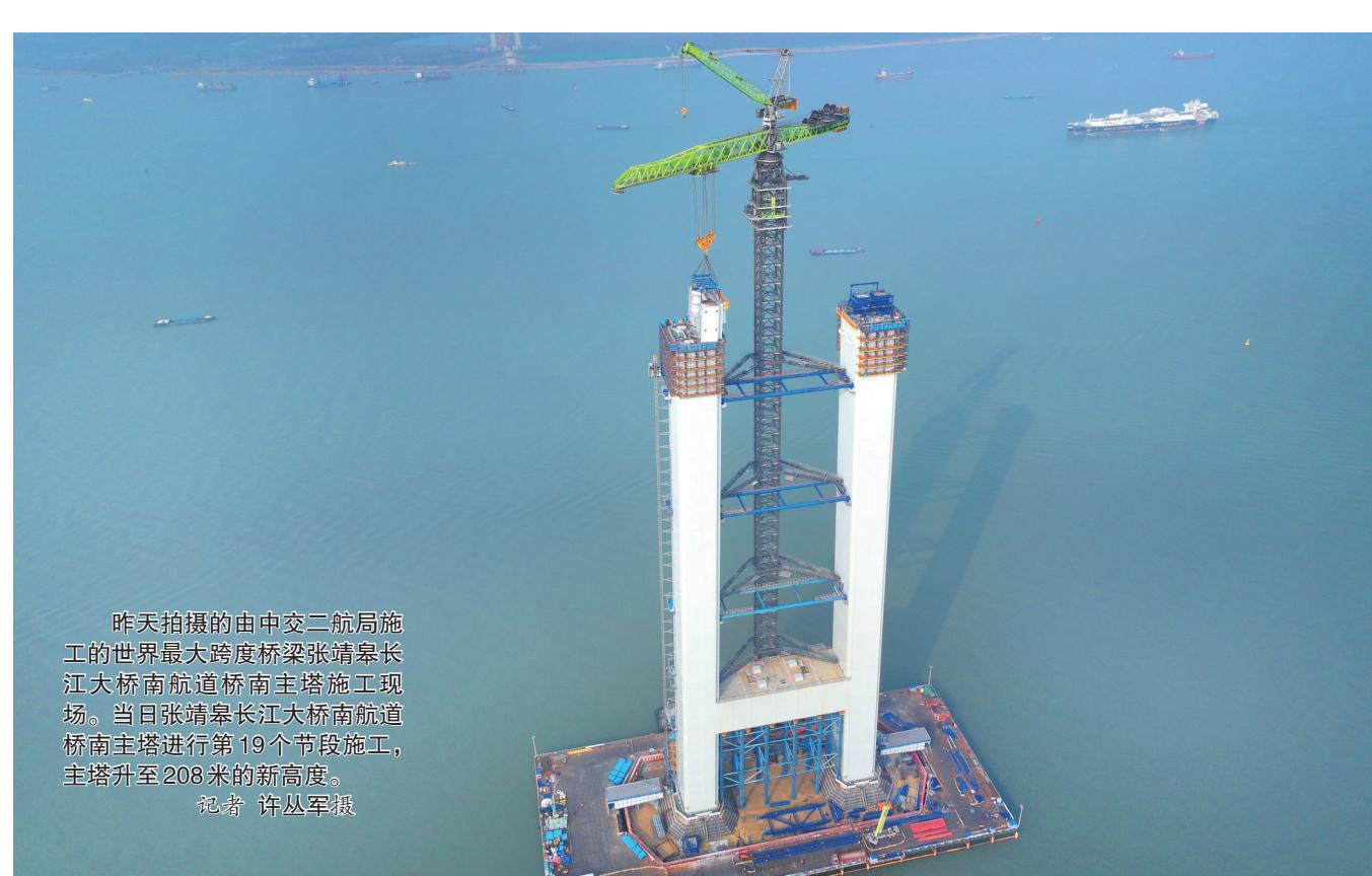
昨天拍摄的由中交二航局施工的世界最大跨径桥梁张靖皋长江大桥南航道桥主塔施工现场。当日张靖皋长江大桥南航道桥主塔进行第19个节段施工，主塔升至208米的新高度。
