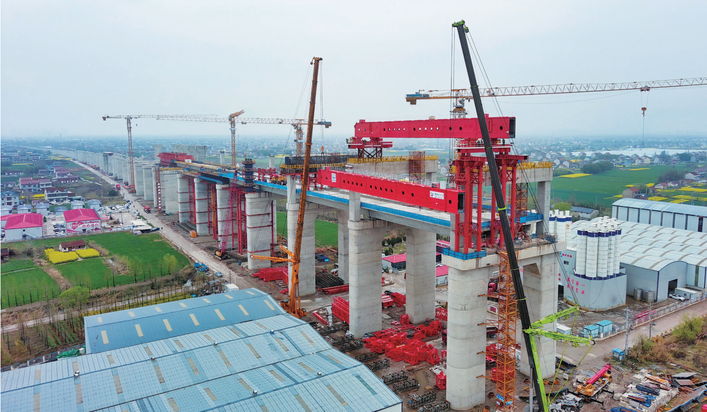
27日，中铁大桥局承建的崇启高铁长江大桥北引桥公路侧移动模架首片主梁开始吊装。崇启高铁长江大桥北引桥公路侧移动模架全长91.4米，重约1200吨，此次吊装的主梁单个重约120吨，负责主桥6号墩至引桥12号墩左右幅24孔上层公路现浇梁施工，计划在今年4月底完成预压。
