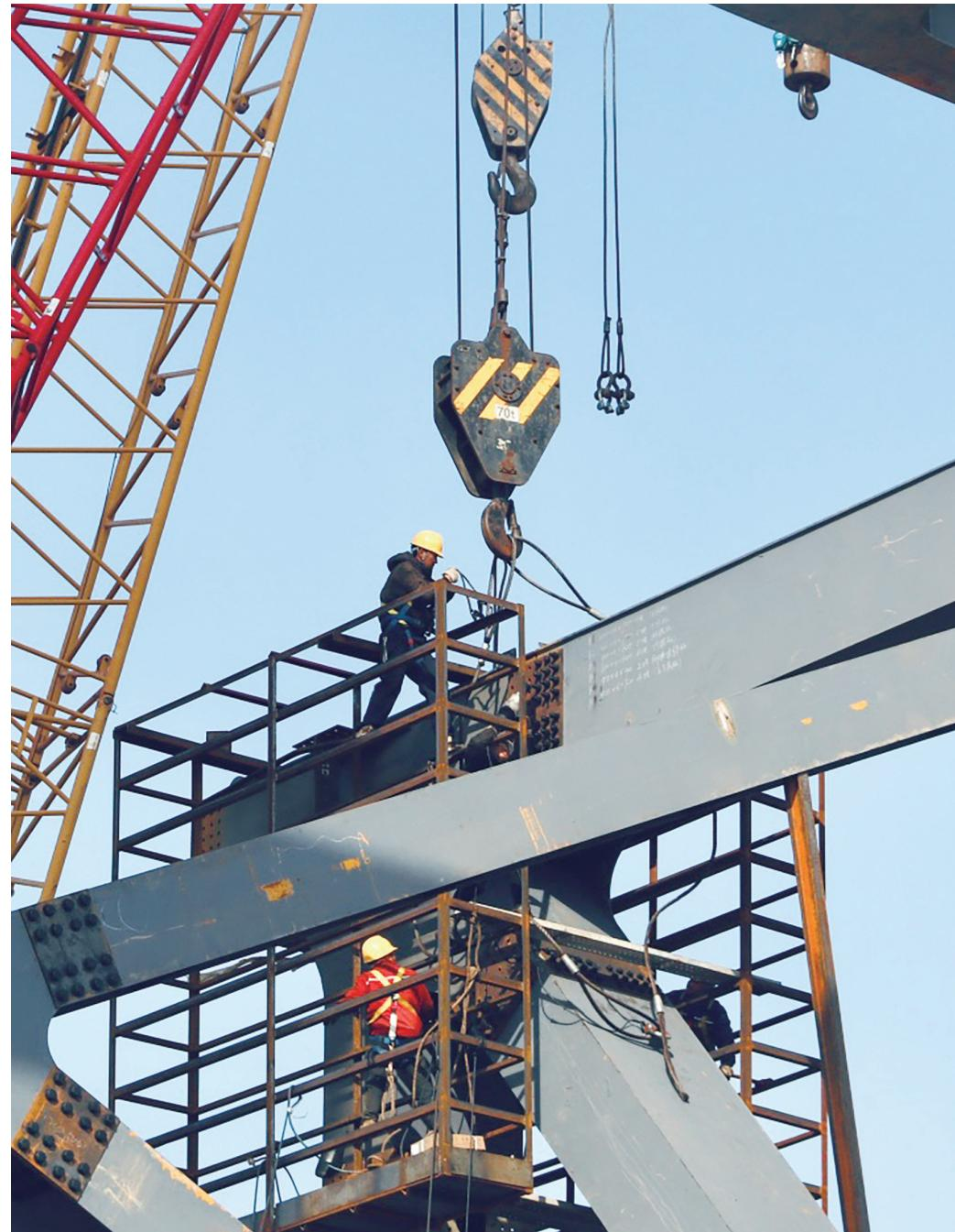
4日,崇启公铁长江大桥3号主塔墩下横梁顶面,由两台800吨米塔吊配合,现场工人正有序吊装上海侧导梁杆件。作为沪渝蓉高铁沪宁段控制性工程的关键环节,此次导梁施工标志着中铁大桥局承建的崇启公铁长江大桥主通航孔桥钢梁施工开始,预计4月下旬导梁拼装完成。通讯员 俞雨森 孟庆虎摄
