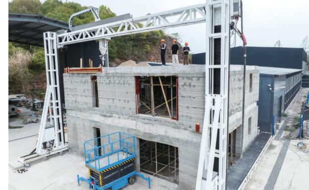
4月9日拍摄的3D打印机建设的双层小楼。近日,在湖北宜昌三峡大学3D打印研发基地试验场,一栋由学校自行研发的12米级龙门式建筑3D打印机建设的双层小楼实现封顶,目前正在斜坡屋顶的施工安装。这栋双层小楼高8米,占地100平方米,比传统建造工期缩短约70%,打印的效率和完整性达到预期效果。新华社照片
