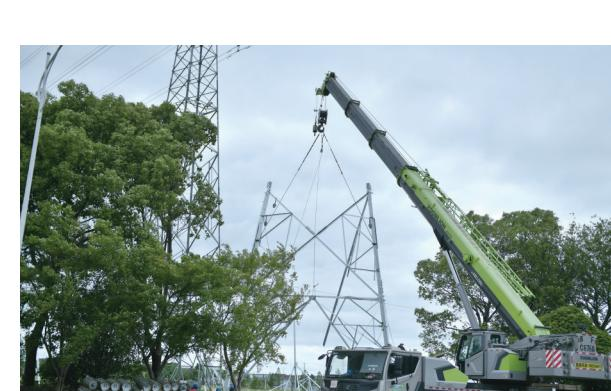
昨天,在海安高新区的江苏金洲粮油集团旁,电力施工人员正在吊装新电塔、架设新线路,以满足用电负荷增长需求。顾华夏摄
