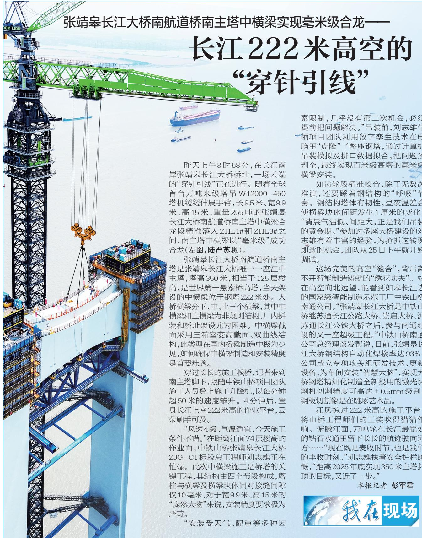
昨天上午8时58分,在长江南岸张靖皋长江大桥桥址,一场云端的“穿针引线”正在进行。随着全球首台万吨米级塔吊W12000—450塔机缓缓伸展手臂,9.5米、宽9.9米、高15米、重量255吨的张靖皋长江大桥南航道桥南主塔中横梁合龙段精准落入ZHL1#和ZHL3#之间,南主塔中横梁以“毫米级”成功合龙(左图,陆严苏摄)。
