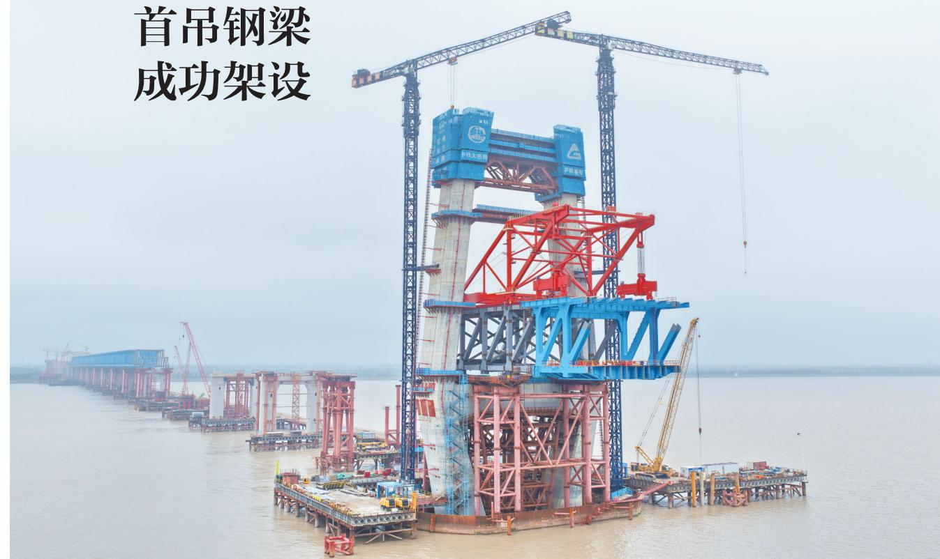
9日拍摄的沪渝蓉高铁崇启公铁长江大桥主通航孔桥刚刚完成首吊钢梁的施工现场。
