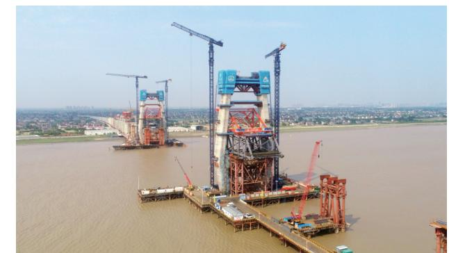
16日11时，随着最后一车混凝土浇筑，由中铁大桥局承建的崇启公铁长江大桥3号墩上横梁混凝土浇筑完成，标志着主塔已进入上塔柱施工阶段。3号墩主塔高153米，共27节，目前已达到109米，按计划9月份3、4号墩主塔可以双双封顶。
