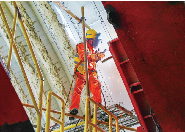
现场施工人员进行管片拼装作业。 通讯员 宋佳摄
