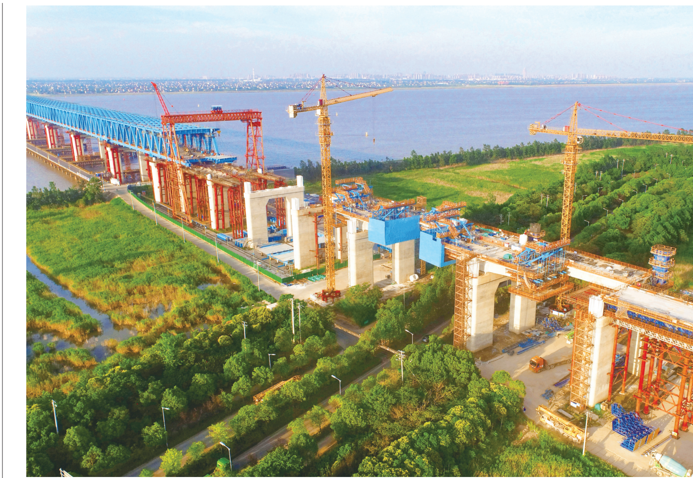
5日,中铁大桥局承建的沪渝蓉高铁V标崇启公铁长江大桥主跨56米跨越长岛大道城际侧连续梁顺利合龙。崇启公铁长江大桥S15~S18号墩铁路连续梁位于南岸引桥公铁合建段,跨度为(36.625+56+36.625)米,主跨56米跨越长岛大道。 记者 彭军君文 通讯员 王世琪摄
