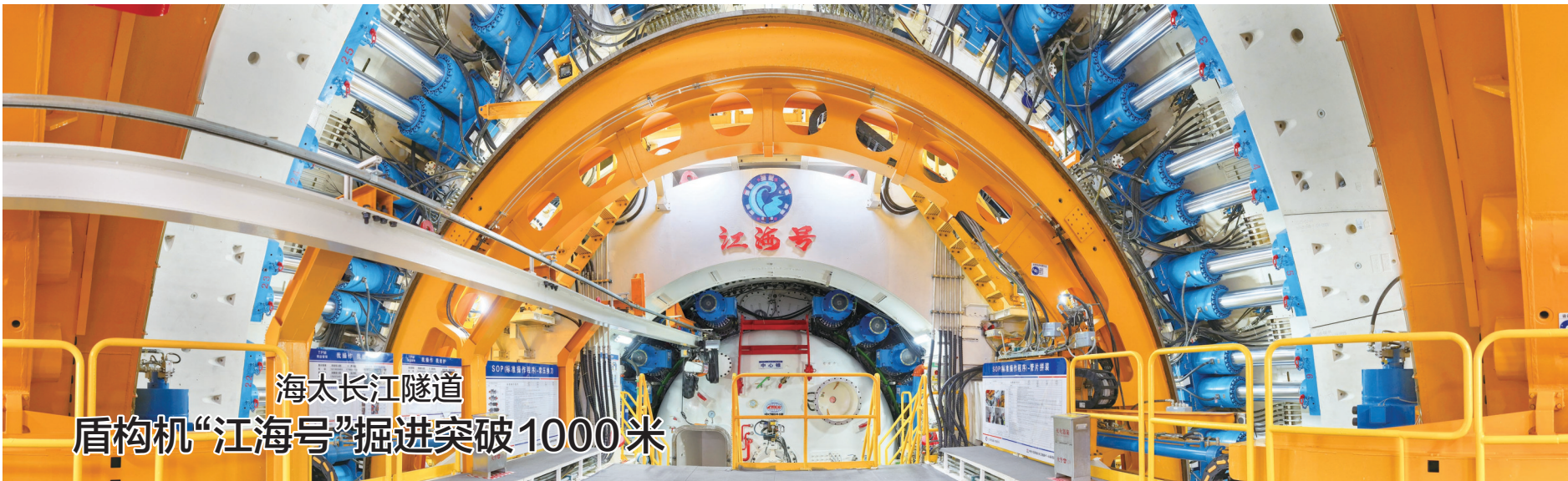
11日凌晨，在海门区地下20余米深处，由中铁十四局承建的海太长江隧道“江海号”盾构机掘进突破500环，累计进尺1000米，标志着目前世界最长公路水下盾构隧道施工取得阶段性进展。 记者 许丛军摄
