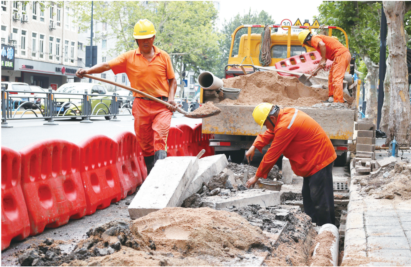
昨天,在市区濠北路与濠东路交叉路口北侧,市政施工人员正对一处小型积水点进行开挖作业,拆除堵塞管道并新建雨水连管。为系统提升城区排水防涝能力,保障汛期雨水排涝畅通,市市政设施管理处持续推进城区积水点动态排查和滚动式治理,坚持“一点一策”精准改造,保障市民出行安全畅通。
