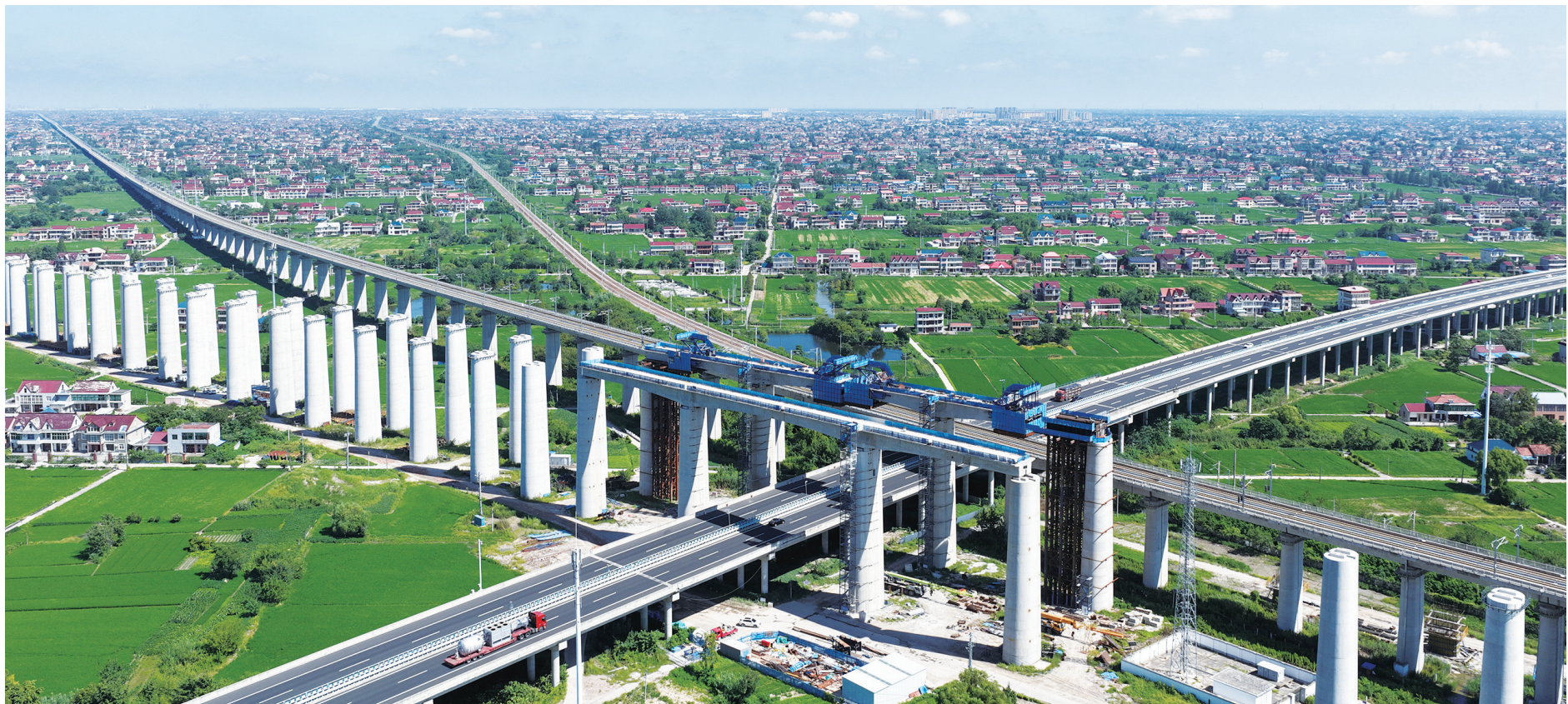
昨天在通州区辖区拍摄的北沿江高铁跨锡通高速施工现场。目前,北沿江高铁江苏段多个控制性节点工程有序推进。
