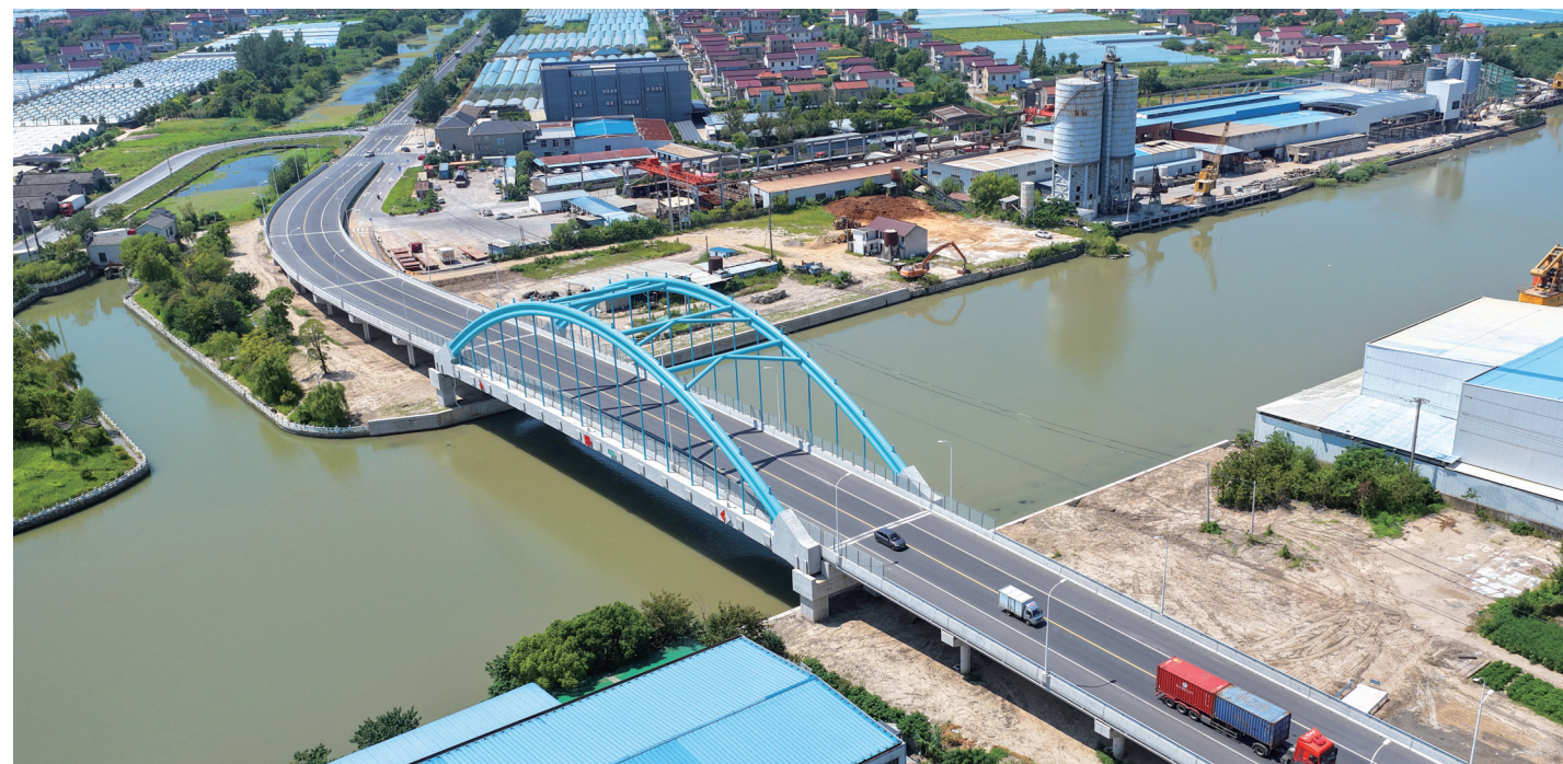
19日在通州区拍摄的通扬线通吕运河二甲大桥。随着上半年二甲大桥的开放通车,通吕运河通州段全线达到三级航道标准,成为通吕运河首个全面达标区段,为千吨船舶的通行提供更加有利的条件。 记者 许丛军摄
