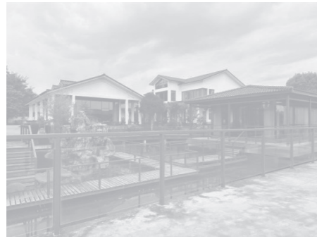
图 12 通州区陈窑村村民张建华利用原住宅修缮改建的新中式乡村别墅
