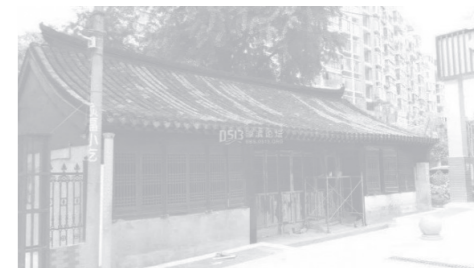
图6 南通丁古角明代住宅
